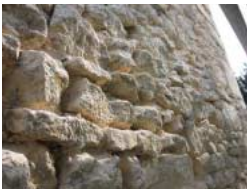
Mur gratté et en attente de l'enduit
