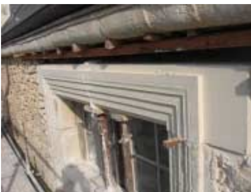
Mur gratté et en attente de l'enduit
