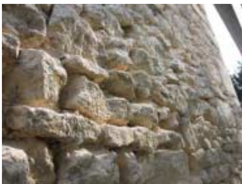
Mur gratté et en attente de l'enduit
