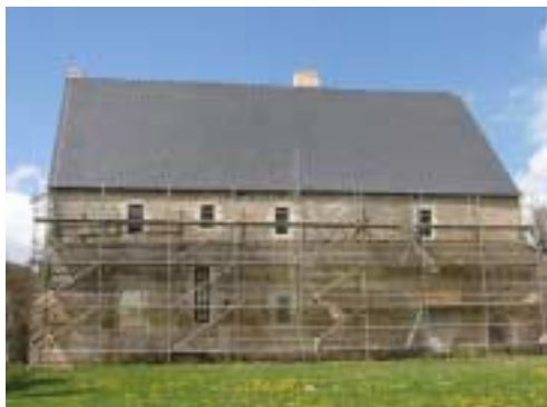
Façade Nord : linteau en cours de pose
