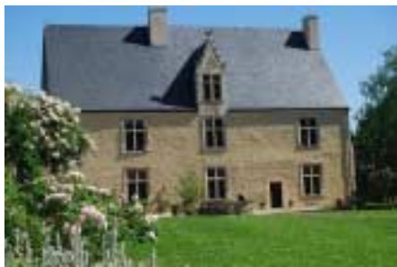
LA FAÇADE NORD
