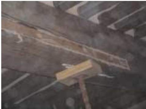
Poutre rebouchée avec une pièce de bois après incision des barres de fibre de verre
