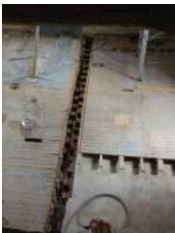
1 er étage : Dégagement du dessus de la poutre du rez-de-chaussée avant renforcement
