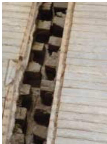
1 er étage : le trou sera comblé par un mélange de béton et fibre de verre pour soutenir par le haut la poutre
