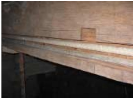
Saignée dans la poutre et renforts par barres de fibre de verre
