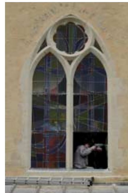
Installation du vitrail
