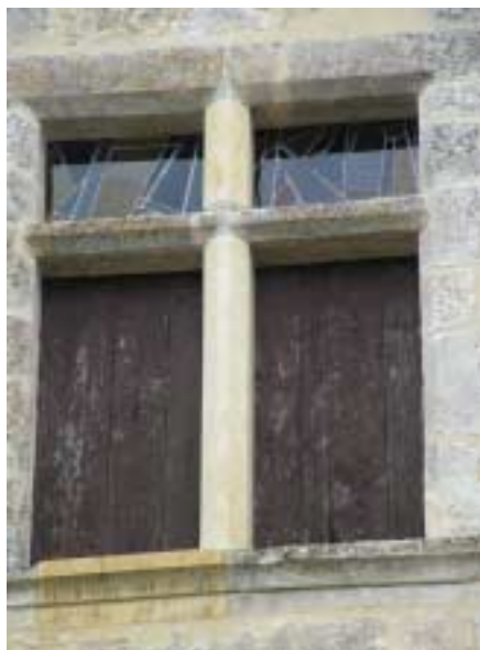
Façade nord : vitraux de la fenêtre à galbe
