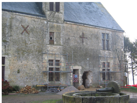
Façade Nord : débouchage de la porte d'entrée XVIème
