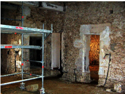
Salle à manger : exemple de piochage des murs avant enduit
